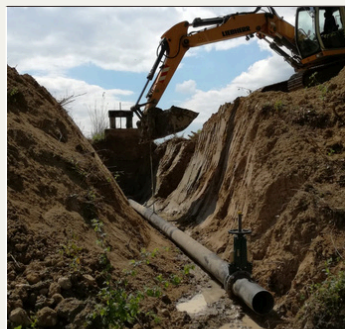
Réfection de vidange d'étang
