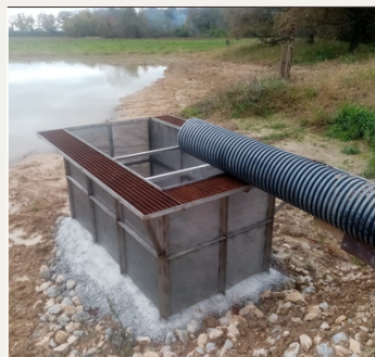
Système de filtration d'arrivée d'eau contre les poissons indésirables, en plaque perforée inox
