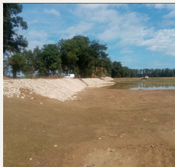
Travaux de consolidation de digue
